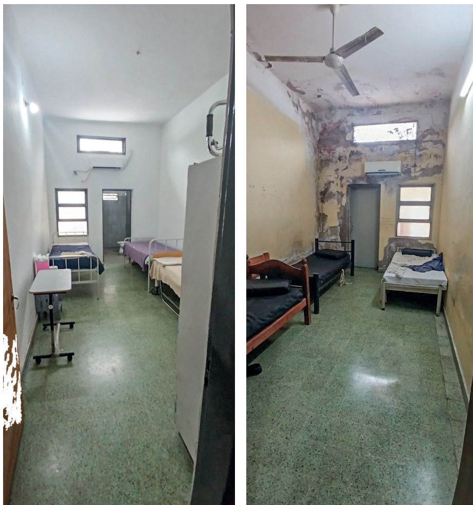
Comparación entre habitaciones reformadas y no reformadas.
